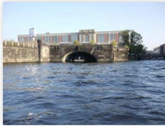
Freiheits- und Einheitsdenkmal in Berlin-Mitte denkmalgeschützt Grundsanierung des Sockels
