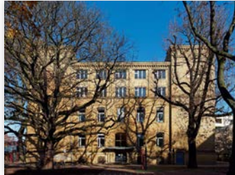
Wrangelstraße 136 in Berlin-Kreuzberg Nürtingen Grundschule (gelbes Haus)
