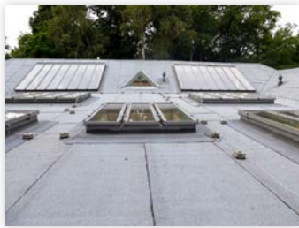
Kinderhaus Waldschulallee in Berlin-Charlottenburg denkmalgeschützt Sanierung des Daches
