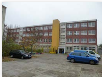
Eisenacher Straße 121 in Berlin - Marzahn Haus des Sportes, errichtet als Schulbau des Typs Berlin 81-GT
