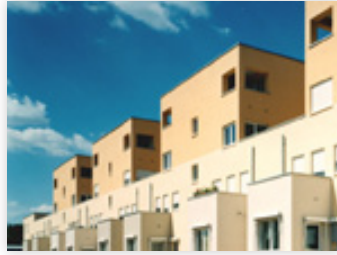
Wohnanlage am Hirschgarten in Berlin-Friedrichshagen Wohnanlage mit 170 Wohnungen und 3.000qm Gewerbe
