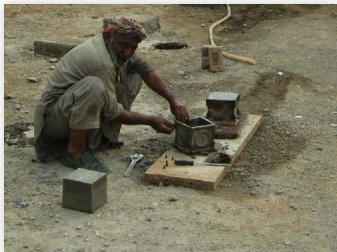
Deutsche Botschaft, Islamabad, Pakistan Umbau und Instandsetzung von Wohnungen
