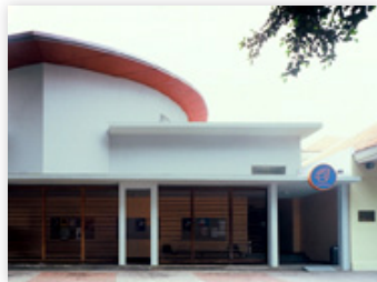
Goethe-Institut in Jakarta, Indonesien Umbau, Erweiterung um ein Saalgebäude und eine Bibliothek, Instandsetzung
