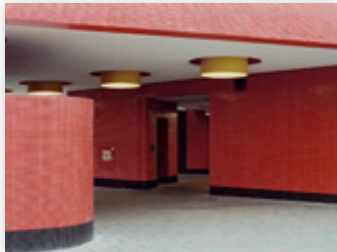
U-Bahnhof Fehrbelliner Platz Umbau und Instandsetzung
