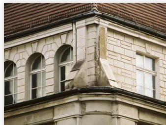
Oberwasserstraße 13 Umbau eines Lager- und Bürogebäudes zu einem Ausbildungszentrum für Diplomaten
