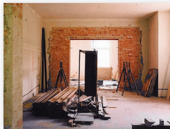
Wohnhaus in Berlin Potsdam/Babelsberg Umbau und Instandsetzung
