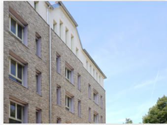
Scharnwebergrundschule in Berlin, Umbau und Instandsetzung
